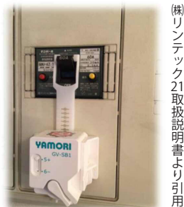
感震ブレーカー（簡易型）
