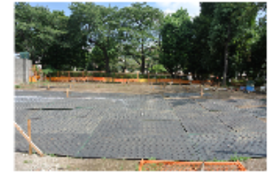
5 池袋本町プレーパーク 造成中
