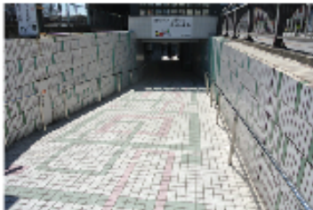
3 池袋駅北口前 ワイロードに手すり設置
